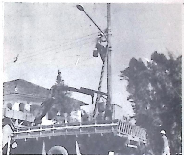
*ENERSUL acabou com o problema de iluminação.*
