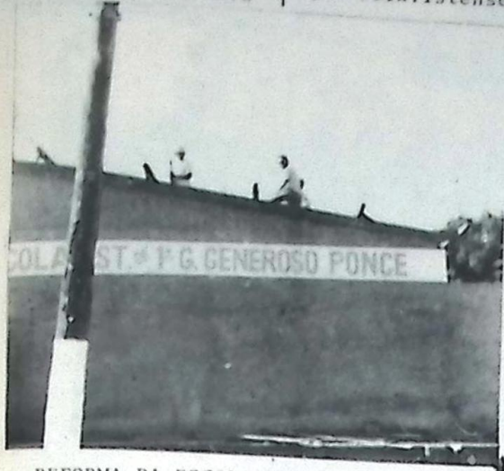
REFORMA DA ESCOLA GENEROSO PONCE.
