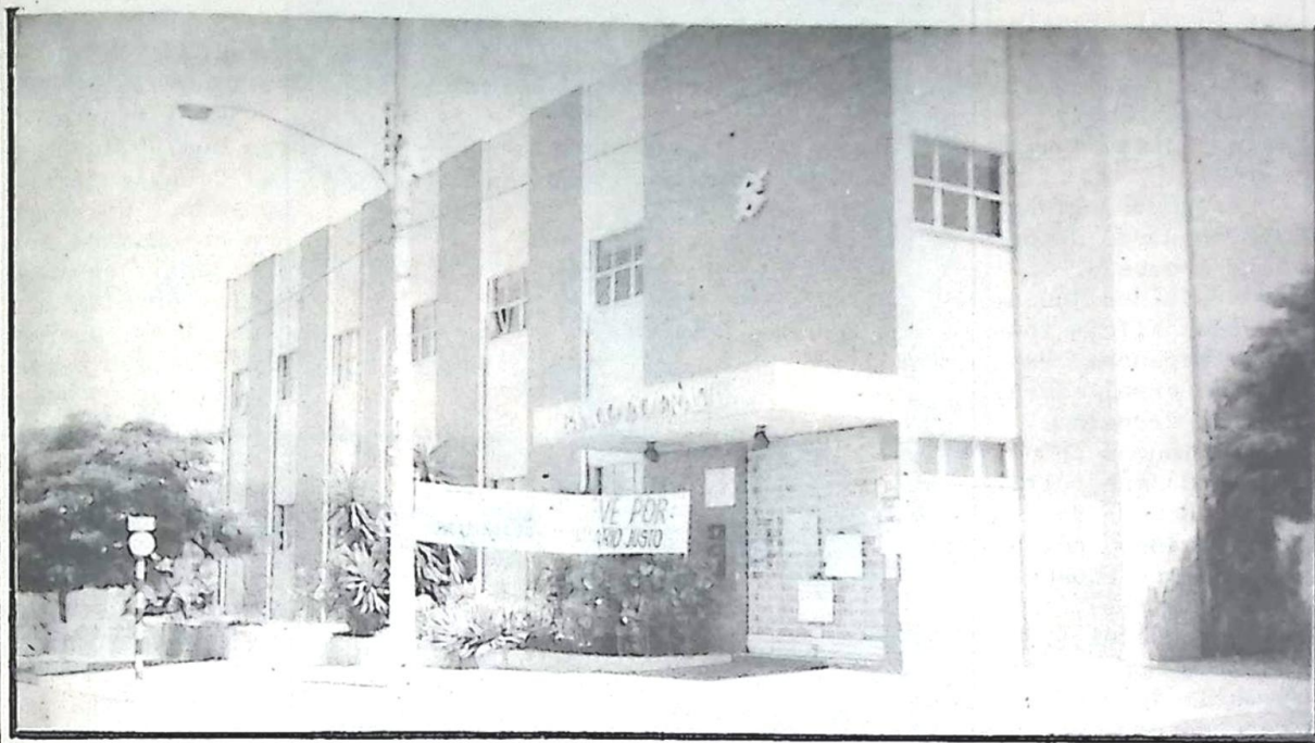
A AGÊNCIA DO BANCO DO BRASIL DE BELA VISTA FECHADA !
