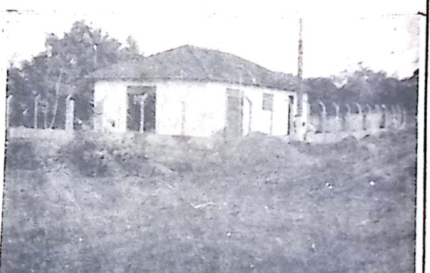
CRECHE EM CONSTRUÇÃO PELA ADM. MUNICIPAL
