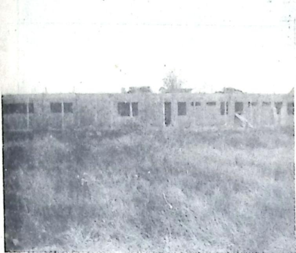
Hotel em Construção
