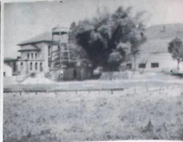
UMA BONITA VISTA DO LOCAL DAS FUTURAS INSTALAÇÕES DO FÓRUM DE NOSSA CIDADE QUE ESTÁ SENDO CONTRUÍDO PELA PREFEITURA MUNICIPAL EM CONVÊNIO COM O GOVERNO DO ESTADO, ATRAVÉS DA SECRETARIA DE OBRAS E QUE TEM COMO ENGENHEIROS RESPONSÁVEIS FERNANDO JORGE DE BARROS E FRANCISCO MONTEIRO FILHO. (Fotos e reportagens Ubaldo Rodrigues).
