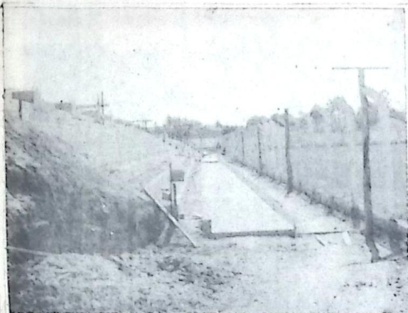
VISTA PARCIAL DAS OBRAS DE CONSTRUÇÃO DAS ARQUIBANCADAS NO ESTÁDIO MUNICIPAL.
