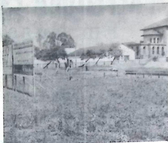
INÍCIO DAS OBRAS DE CONSTRUÇÃO DO EDIFÍCIO DO FÓRUM DE 1ª ENTRÂNCIA.
