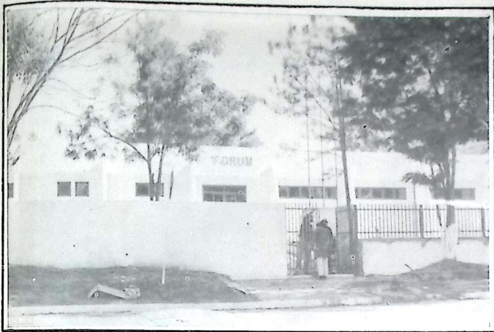
NOVO FÓRUM DA COMARCA DE BELA VISTA, CONSTRUÍDO PELA PREFEITURA MUNICIPAL EM CONVÊNIO COM A SECRETARIA DE JUSTIÇA DO ESTADO DE MATO GROSSO DO SUL E QUE ESTARÁ SENDO INAUGURADO NESTE DIA 20 COM A PRESENÇA DO GOVERNADOR DO ESTADO MARCELO MIRANDA SOARES.
