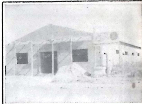
CRFCH CONSTRUÍDA PELA FUNDAÇÃO TRIBUNA DA FRONTEIRA COM APOIO DA PREFEITURA MUNICIPAL DE BELA VISTA.
