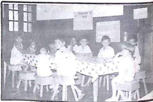
CRECHE IRMÃ ANGELINA - NA ANTIGA CASA DAS FREIRAS.
