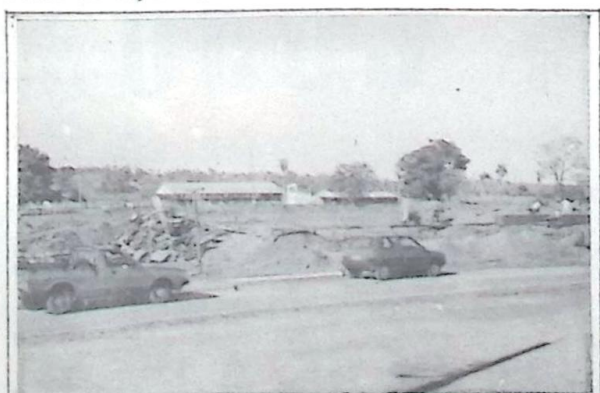
Vista parcial das obras de construção do novo Clube do Laço Bela Vista que está sendo edificado no recinto do Parque de Exposições Rio Apa e será uma das mais modernas instalações, oferecendo todo o conforto e ambiente acolhedor.
