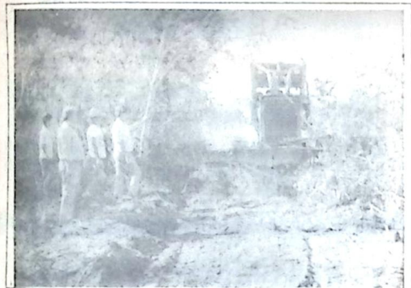
Trabalhos de abertura de ruas, contendo com tratores cedidos por companheiros e de propriedade particular do Prefeito Municipal.
