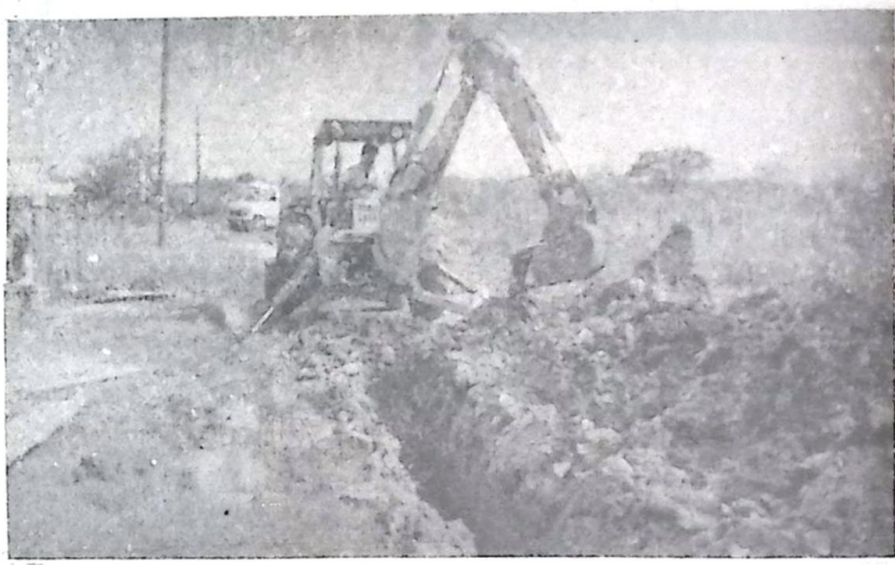
Serviços de extensão de redes de água, uma realidade na atual administração de Porto Murtinho.
