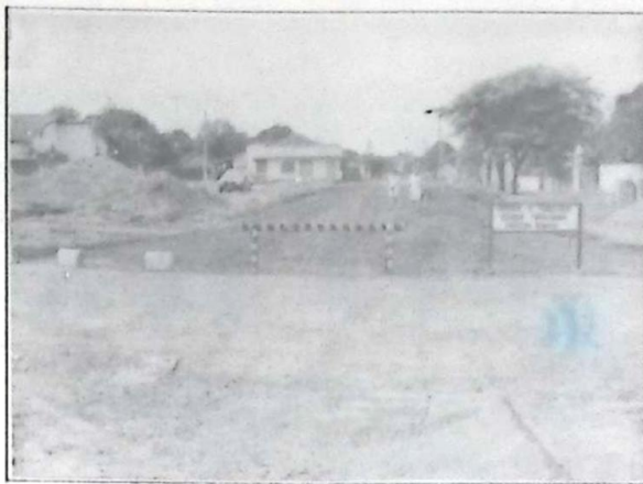
Trecho da Rua Santo Afonso com suas obras em fase adiantada e já recebendo as primeiras camadas de "píche".
