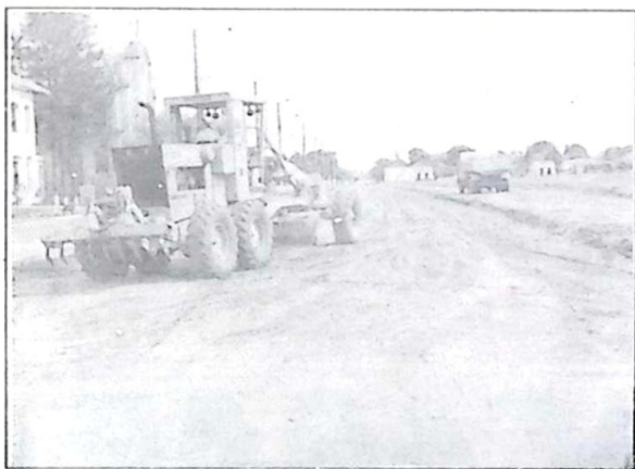
Serviços de terraplanagem e nivelamento das ruas realizados com todo o cuidado para que o asfaltamento não venha a sofrer deterioração futuramente, sempre sob a orientação do Engenheiro Marcos Moraes (Duty), responsável pelos serviços.
