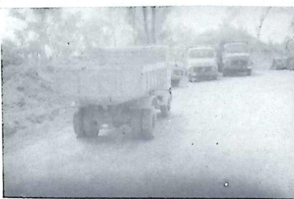
Veículos e máquinas na estrada da "Pirapoca"
