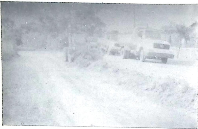
ENTULHOS DAS RUAS
