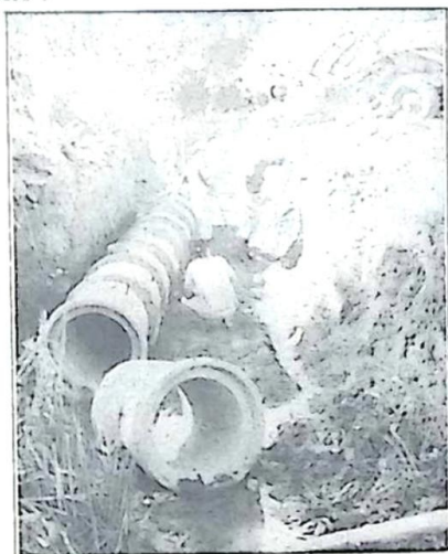
CANALIZAÇÃO DE CÔRREGO NA RUA MARECHAL DEODORO, TRANSVERSAL COM A SOARES DA ROCHA QUE SERÁ ASFALTADA.
