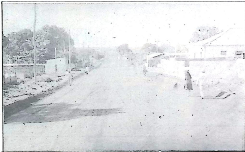
Trecho da Rua General Soares da Rocha já imprimada e pronta para receber a capa asfáltica
