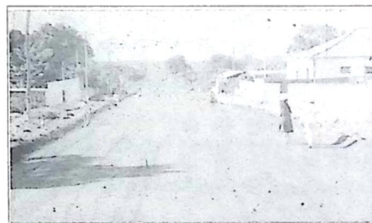
VISTA DA SOARES DA ROCHA JÁ IMPRIMADA E PRONTA PARA RECEBER A CAPA ASFALTICA.
