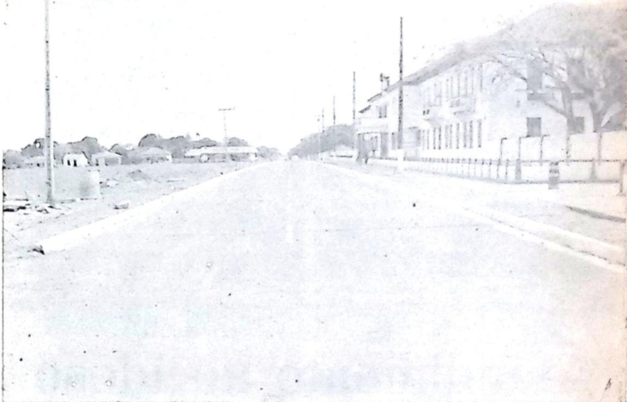
VISTA PARCIAL DAS OBRAS DE ASFALTAMENTO EXECUTADAS PELA PREFEITURA NUM TOTAL DE 45.500m 2
