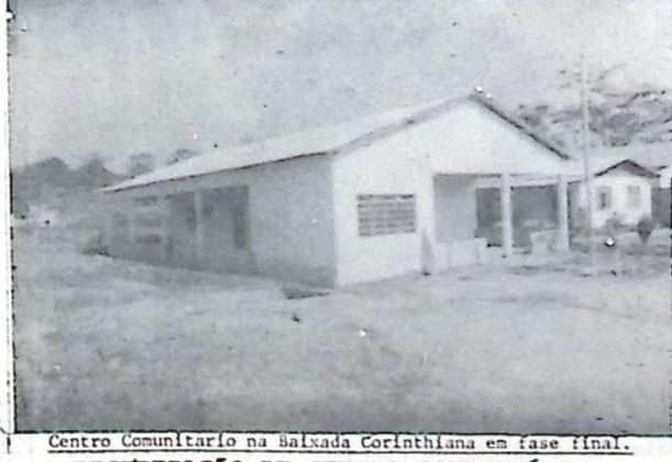
Centro Comunitário na Baixada Corinthiana em fase final.
