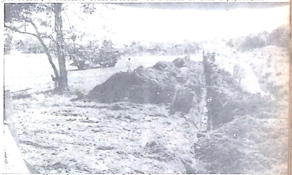
Obras de Saneamento Básico já iniciadas em Bela Vista.
