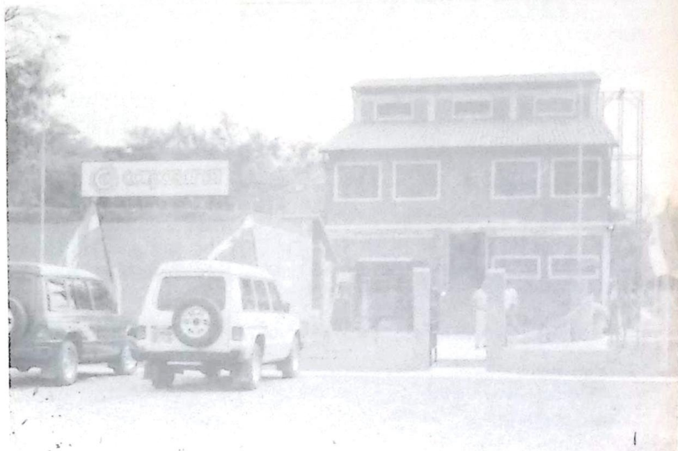
Vista da fachada principal das instalações do Serviço de Abastecimento de Água Potável em Bella Vista
