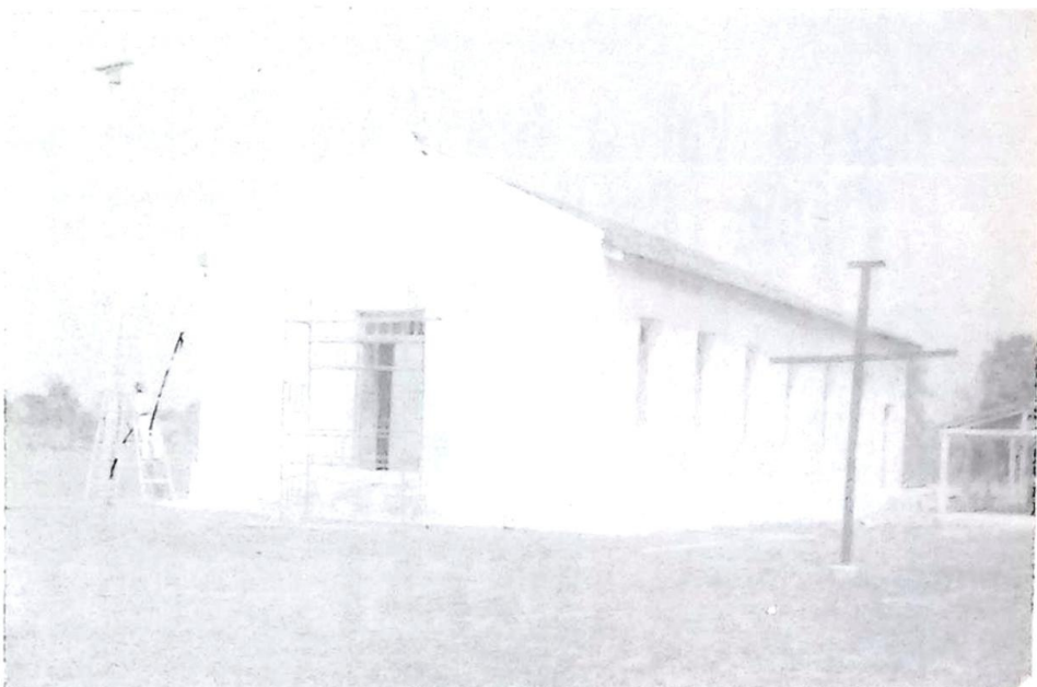
Capela de São Clemente, com novo visual após receber serviços de pinturas
