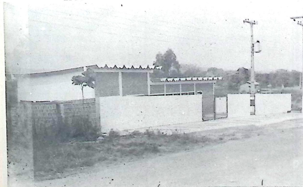
PRÉDIO DA "VACA MECÂNICA" APARELHADO COM MODERNOS EQUIPAMENTOS PARA PRODUIR MIL LITROS DE LEITE DE SOJA POR DIA.
