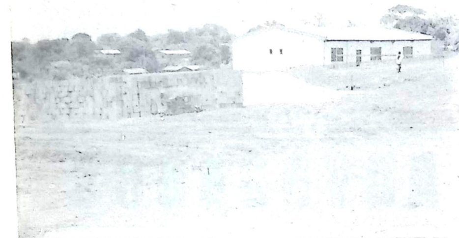
Como no bairro das Primaveras, com os materiais já encostados e terreno nivelado.
