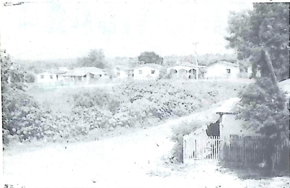
Vista parcial do Conjunto Residencial Dr. Ely de Araújo Barbosa
