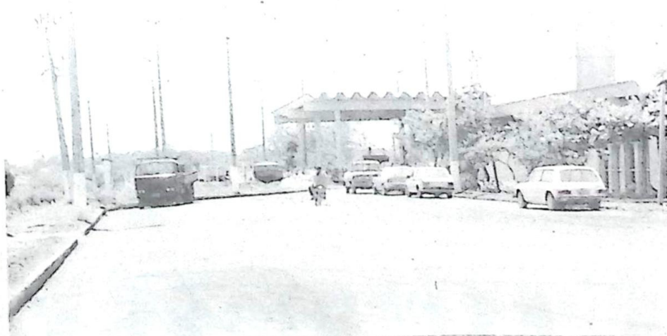
Avenida Internacional, um novo visual
