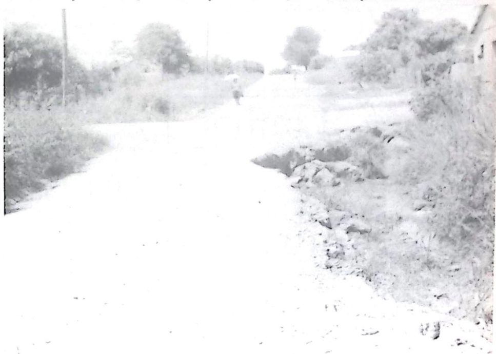
A erosão já avança sobre a Rua Ricardo Loureiro
