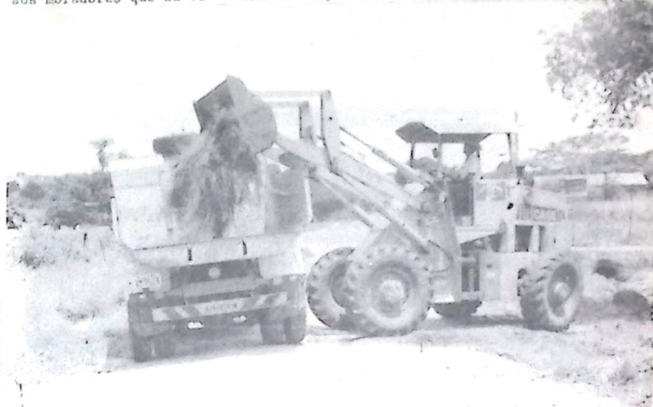
Máquinas e Caminhões fizeram a remoção dos entulhos
