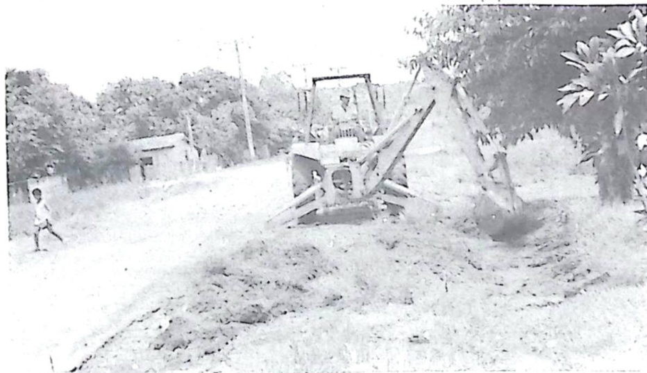
Retro escavadeira faz a limpeza dos canais de escoamento das águas
