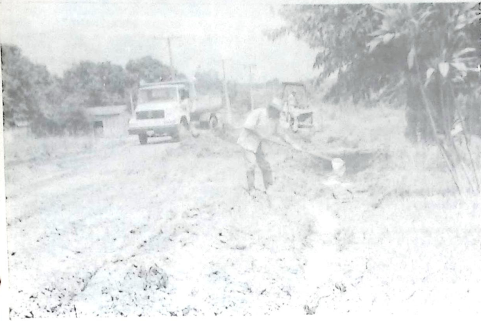
Homens e máquinas trabalhando
