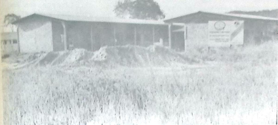
Dois Colégios estão sendo construídos: um com quatro salas nos altos da Vila Donária (foto) e outro com duas salas na Vila Marambaia
