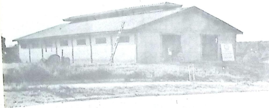
Obra do Mercado Municipal está em fase de acabamento
