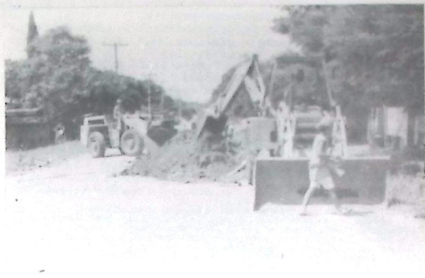
Implantação da rede de esgotos em execução
