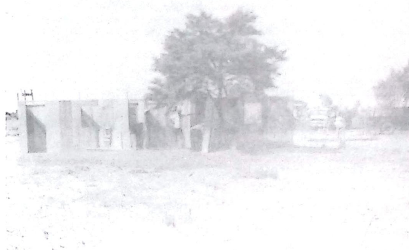
A firma empreiteira já está montando o acampamento na área do Conjunto
