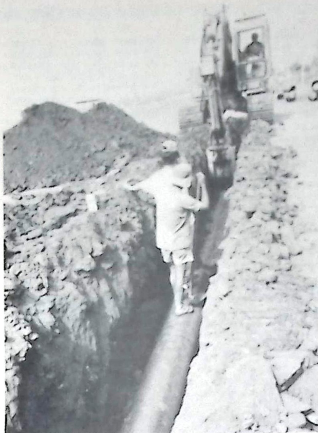
Obras de instalação de esgoto: a garantia de saúde aos cidadãos
