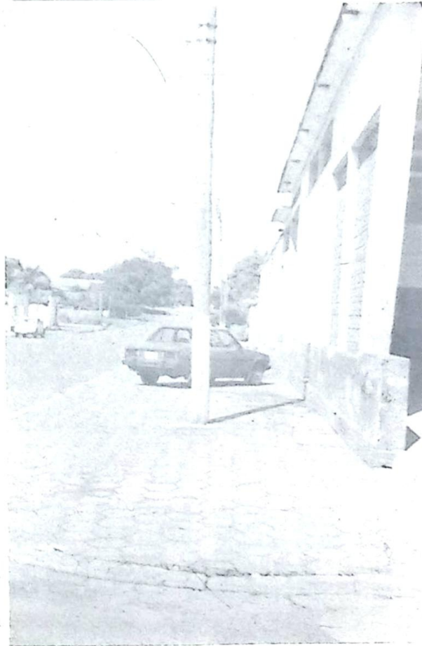
Na frente do Clube, mais 510 m 2 de calçadas foram construídas
