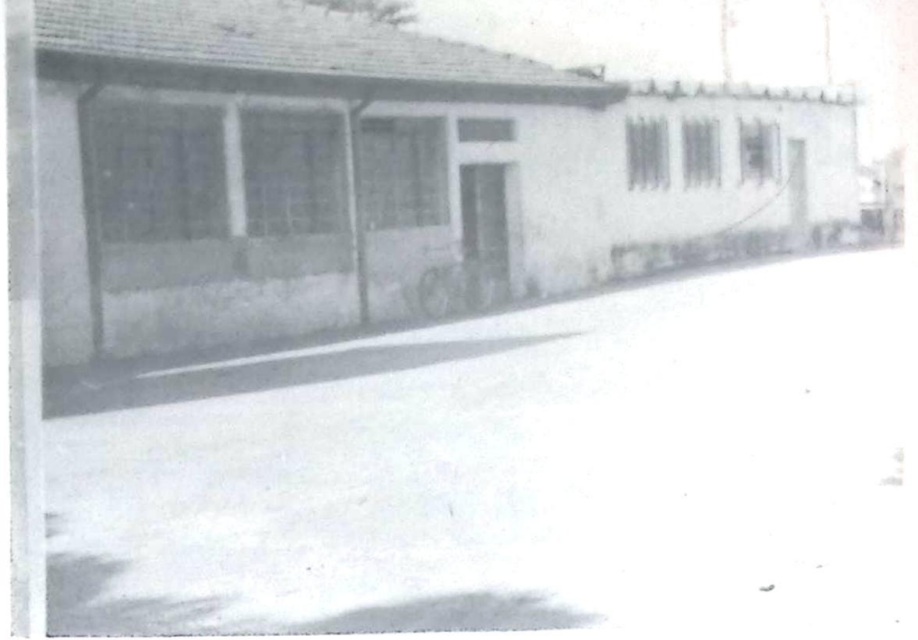
Pátio dos fundos, todo calçado, com 535m 2 de concretagem
