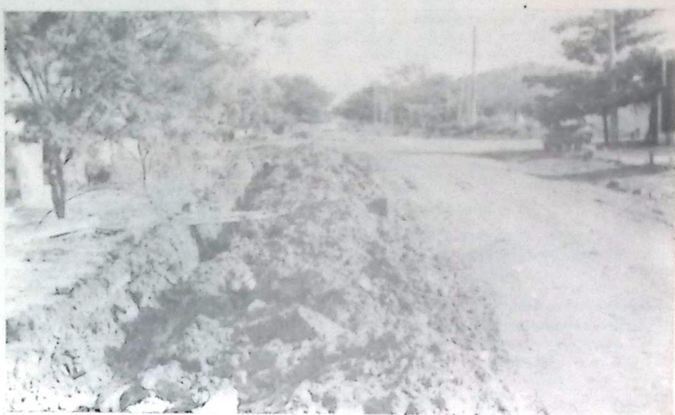
Muitas ruas foram drenadas e receberam tubos de cimento nas laterais
