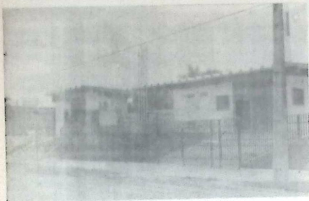
Central Telefônica - TELEMS
