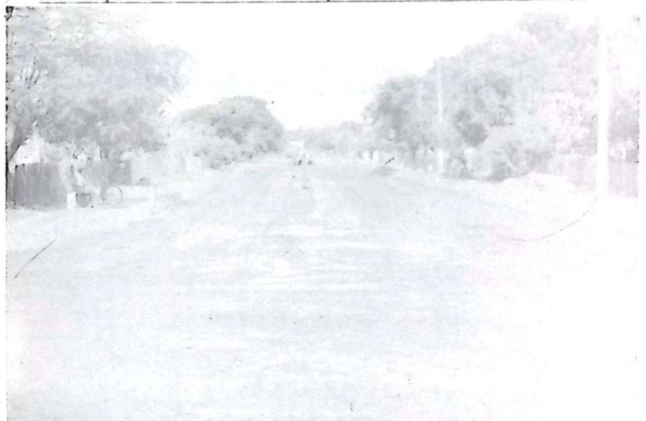
Trecho da Rua Artur Velozo, já imprimida e pronta para receber a capa asfáltica
