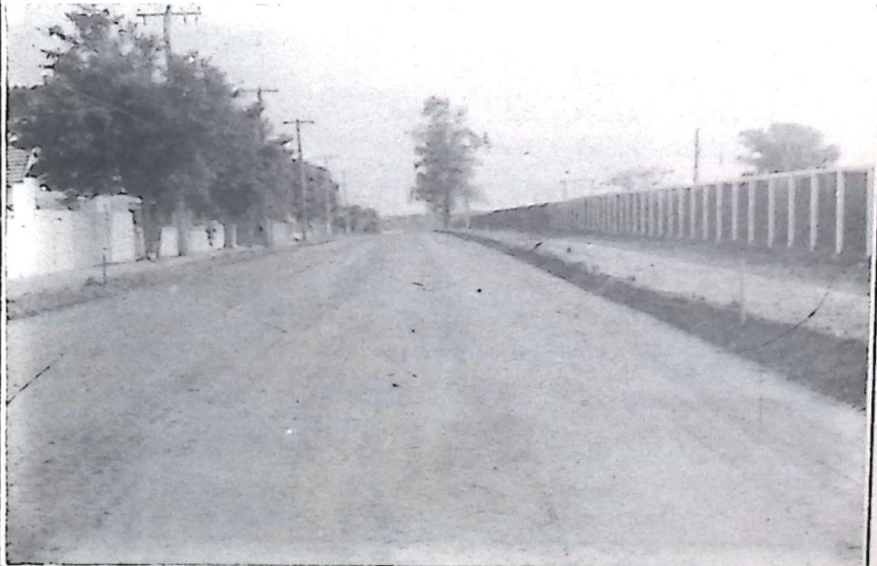
Rua Duque de Caxias, paralela ao 102 RC Mec já emprimada e pronta para receber a capa asfáltica
