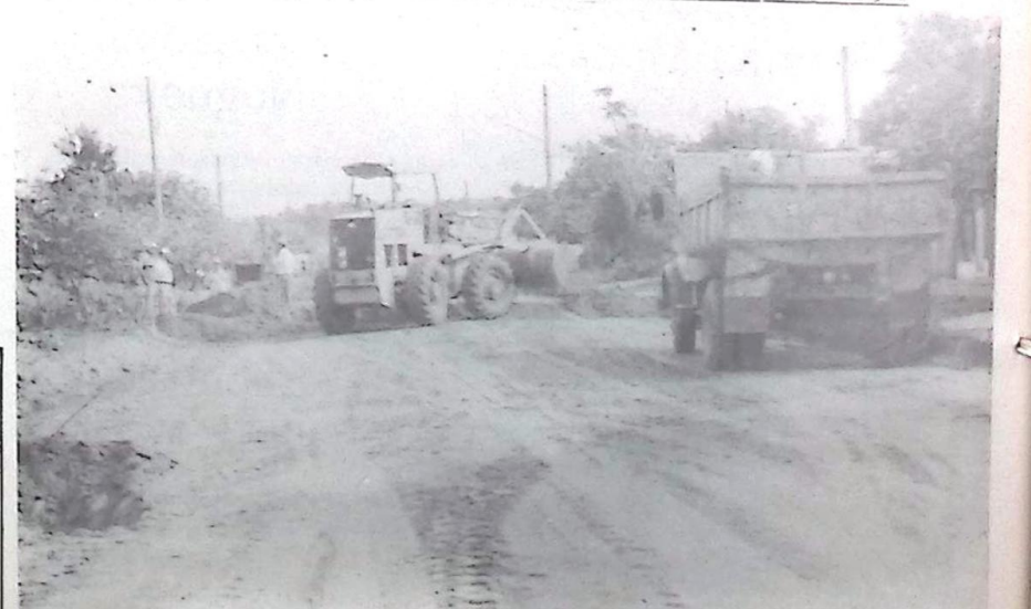
Máquinas e homens trabalham na Rua Álvares Cabral
