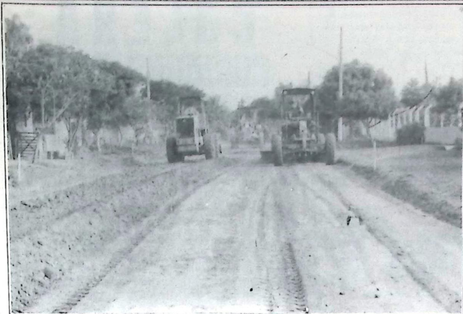
Máquinas da Prefeitura e do Exército trabalham em ritmo acelerado no Bairro Antonio João
