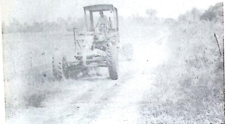
Através do Consórcio Intermunicipal as Rodovias e estradas vicinais do Município e da região foram conservadas
