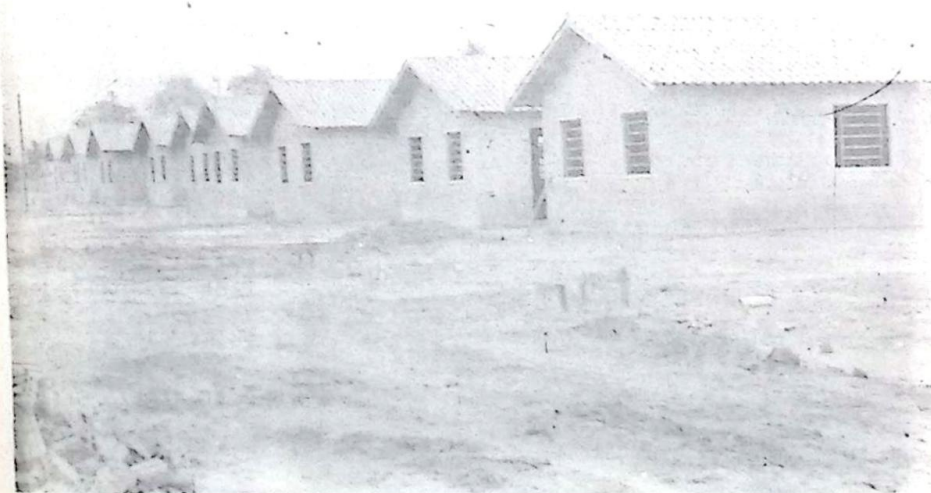
Conjunto habitacional em construção nos altos do Bairro Itaboraí
