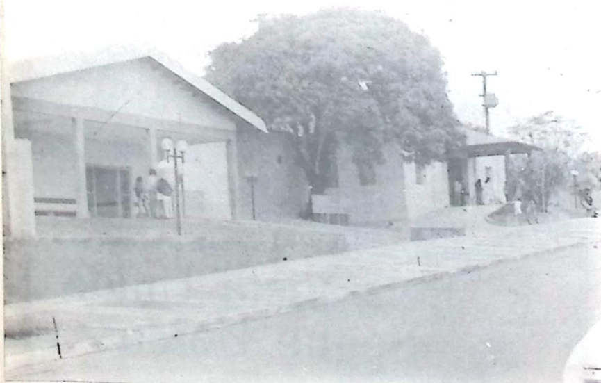
Vista da frente do novo e moderno Hospital São Vicente de Paula
