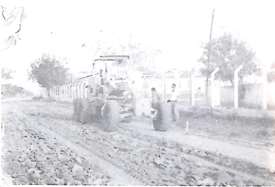
Sob a supervisão do Engº Marcos Câmara, as máquinas da Secretaria de Obras entraram ontem na Cohab
