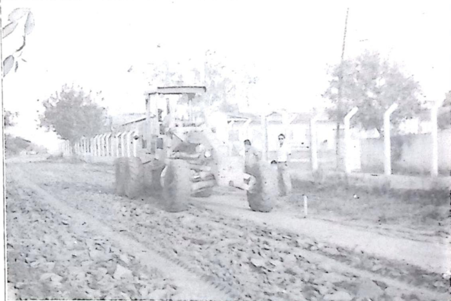
Sec. de Obras já iniciou os trabalhos no Conjunto Dr. Ely
