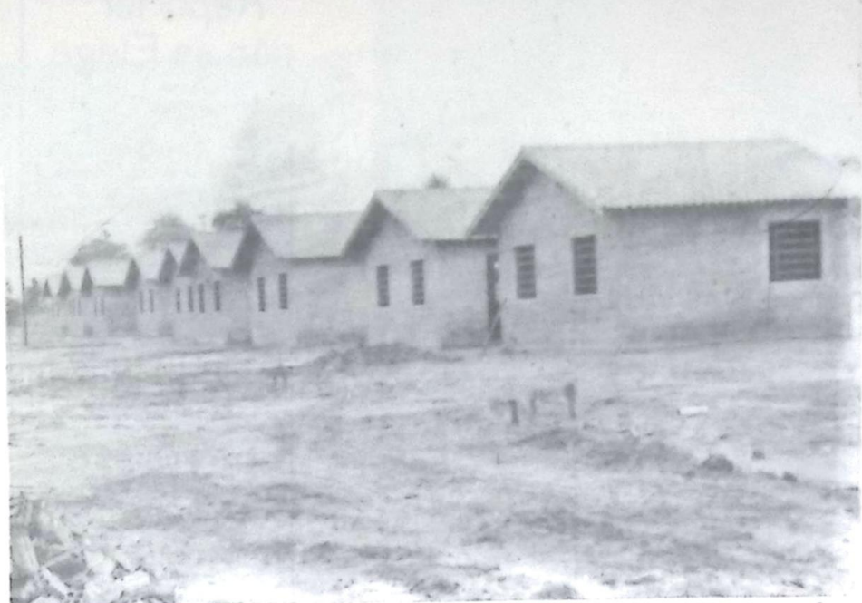
Casas do Conj. Vila do Boiadeiro, em construção no Bairro Itaboraí
