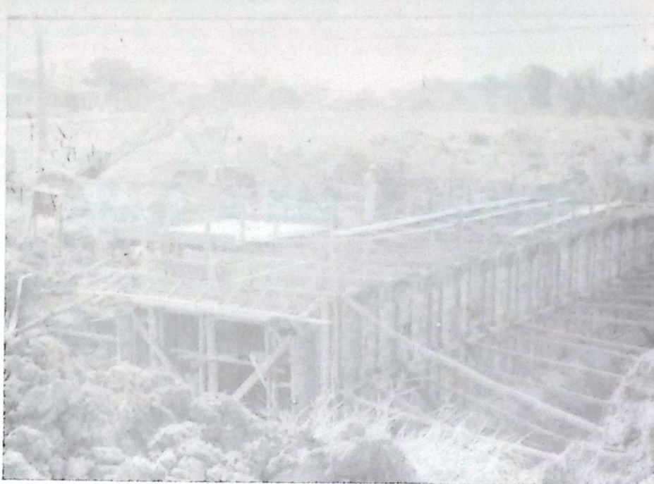
Na entrada da cidade, próximo ao BNH, está sendo construída uma ponte de cimento armado
