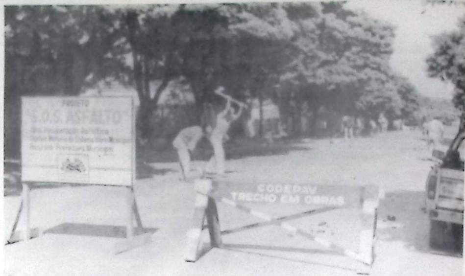
Operação Tapa Buracos, continua a todo vapor
