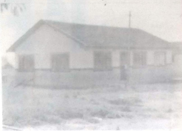
Prédio da PRONAV totalmente reformado pela atual Administração
