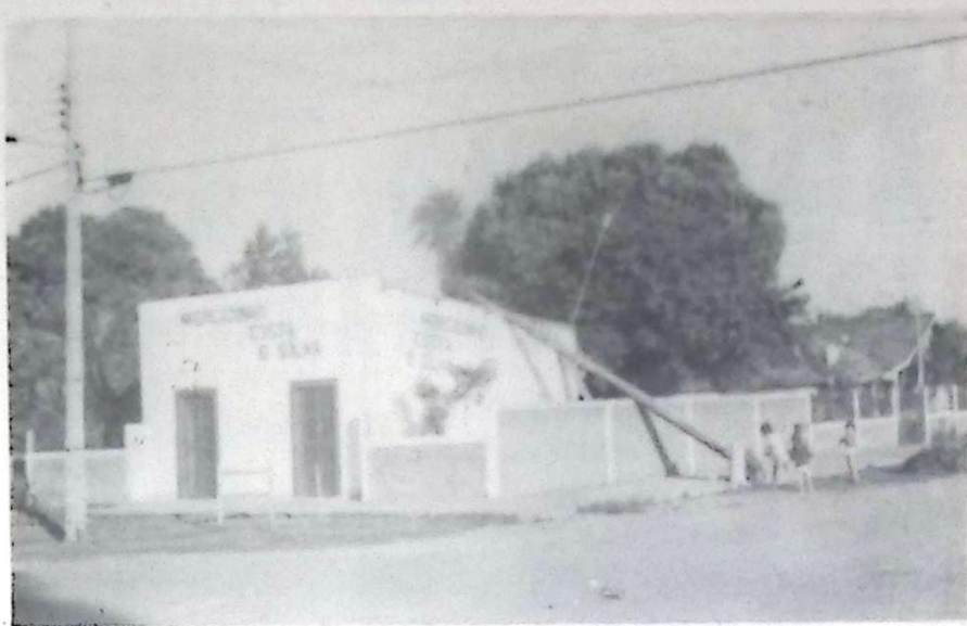
Plagante do salão atingido pelo poste de energia
