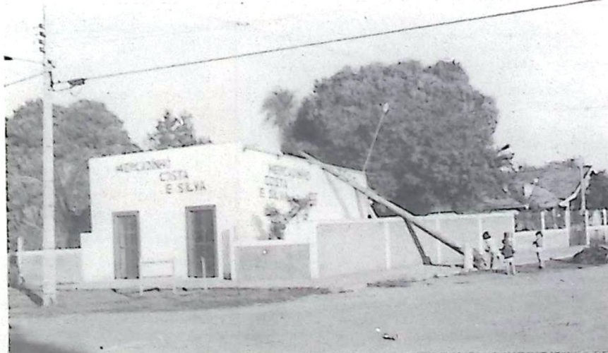
Flagrante do salão atingido pelo poste de energia
