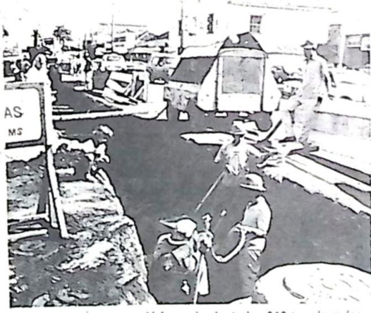
Obras de Saneamento. Já foram implantados 310 km de redes de distribuição de água em todo o Estado.
