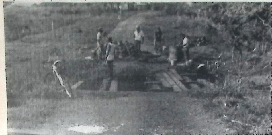
Implantou o início das obras de construção de 250 casas do Projeto de Desfavelamento do Município; - Construção da Escola Municipal da Vila Santa Tereza, recursos repassados pelo MEC.
