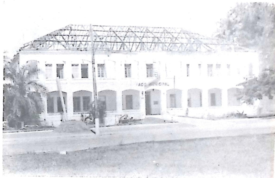
Vista do prédio do Paço Municipal que está com a sua cobertura sendo totalmente recuperada
