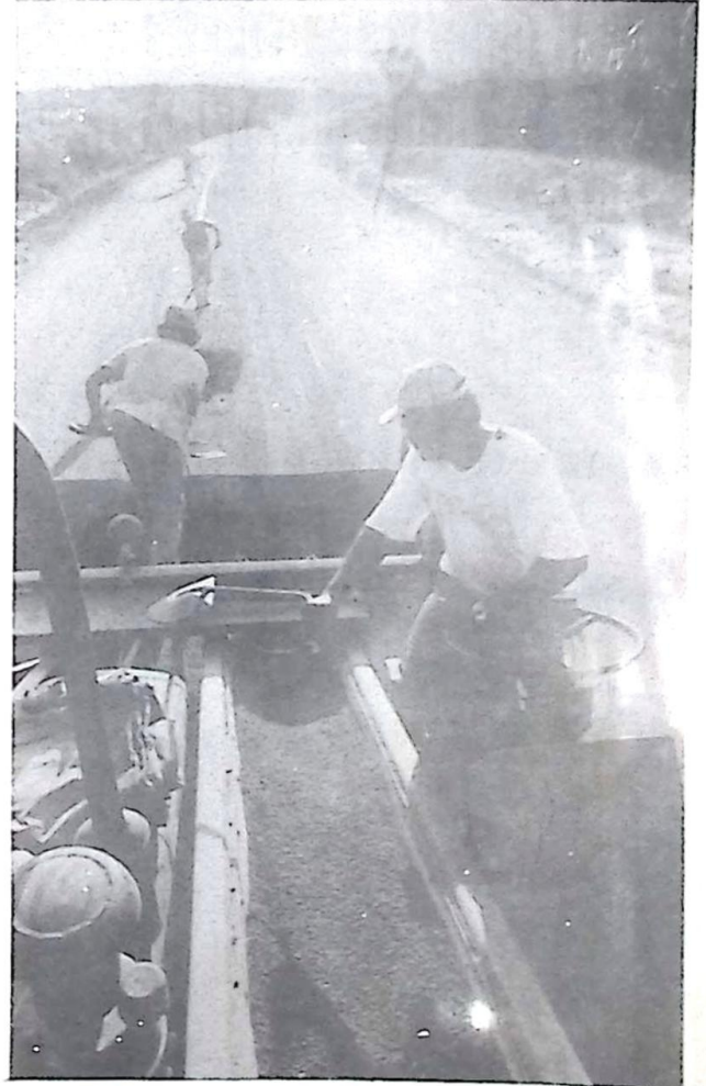
A BR-060, trecho Bela Vista/Jardim, está com mais de 70% do asfalto concluído. Pedrossian concretiza o antigo sonho dos belavistenses
