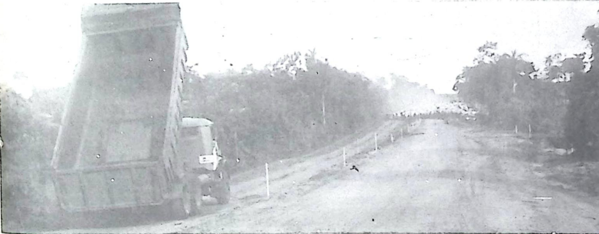
O ritmo é acelerado nas obras de asfaltamento da Rodovia Jardim/Porto Murtinho
