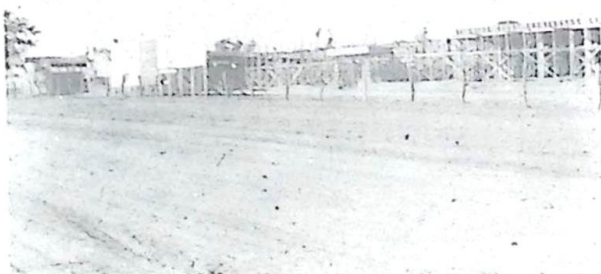
Vista das obras de construção do Centro Universitário de Jardim
