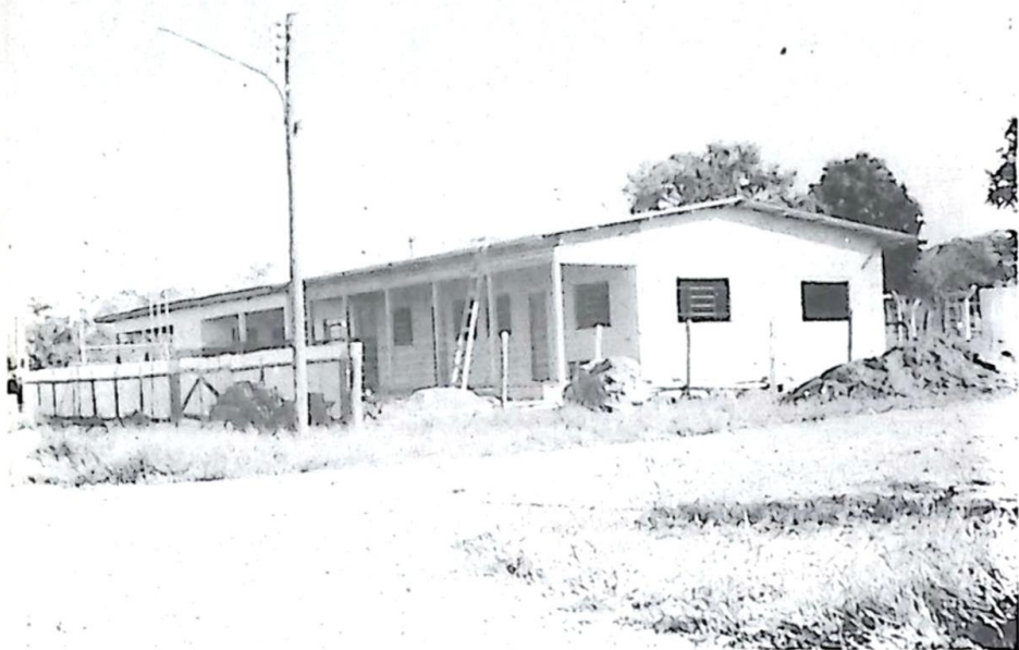
As Escolas da Vila Machado e Vila América foram ampliadas em mais duas salas de aulas
