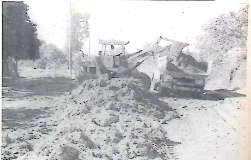
A movimentação de máquinas e homens da Prefeitura Municipal, na execução do Projeto Bandeirante transformam o visual dos bairros Espírito Santo, Itaverá e Clarão da Lua.
