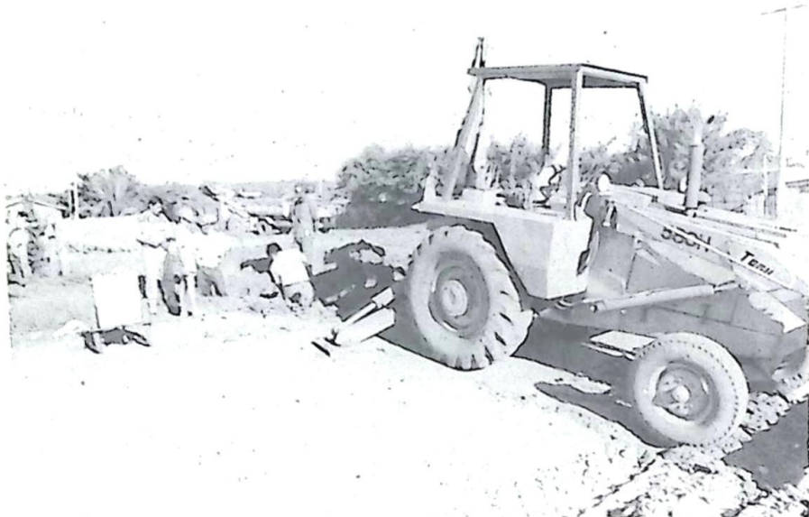
Extensões da rede e ligações domiciliares foi um importante trabalho executado pelo SAAE
