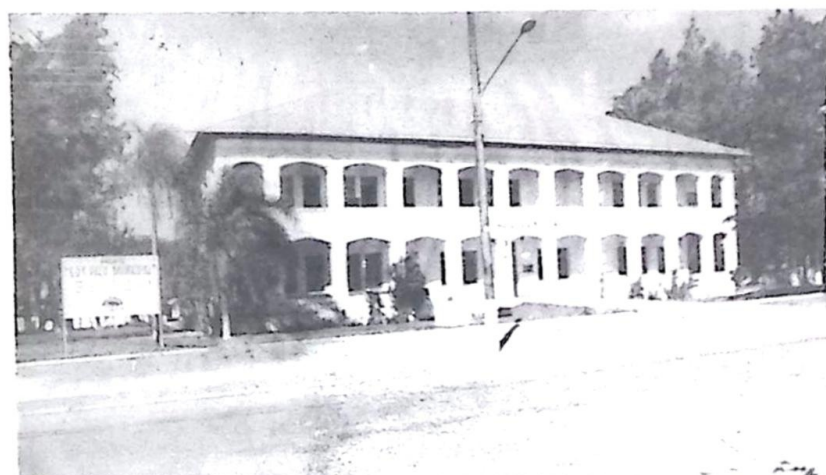
O Paço Municipal de Bela Vista está com suas obras de reforma em fase de conclusão
