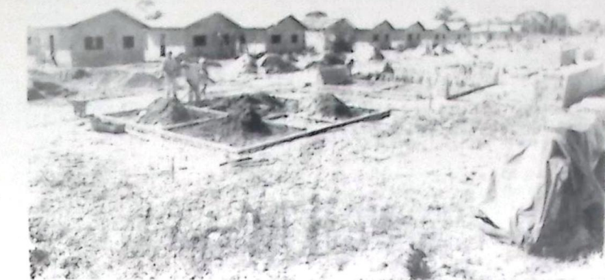
As últimas 25 casas dessa primeira etapa já estão em fase de construção
